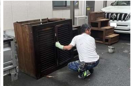
箱階段に塗られたペンキを落としていきます
