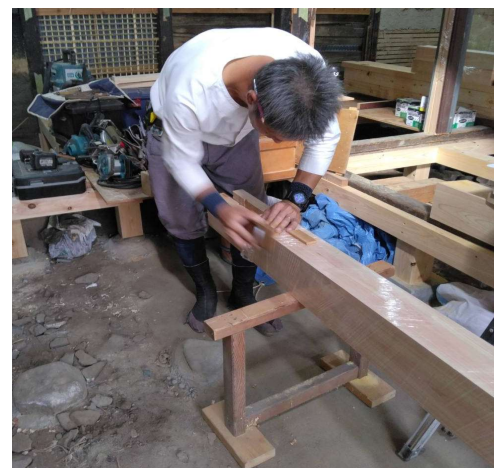
写真3：車知栓の微調整
