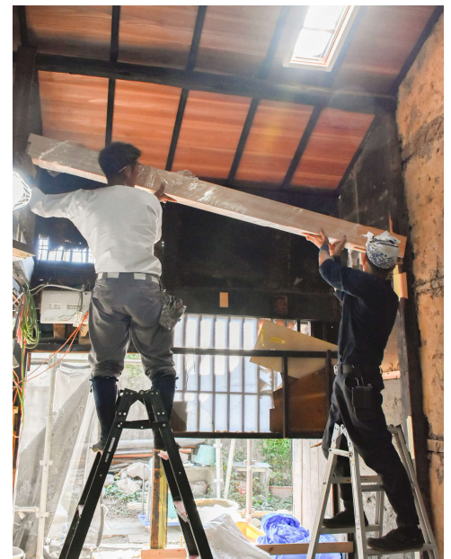
写真2：梁の架け替え
